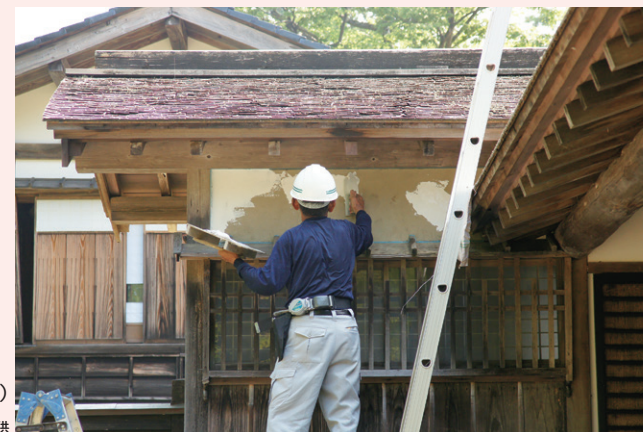
重要文化財 旧長谷川家住宅の修理(長岡市)
