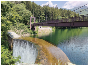
大源太川第1号砂防堰堤
