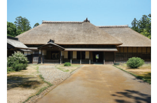
旧長谷川家住宅・主屋
