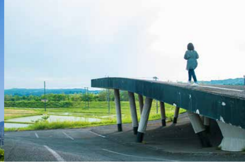
アスファルト・スポット R&S建築事務所
