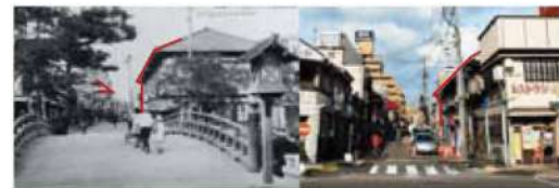
白山神社前から見た古町通。左の写真は大正~昭和初期のもの、右は2009年のアーケード工事中のものです。赤い線をひいた建物が、同じ位置に残っているのがわかります
