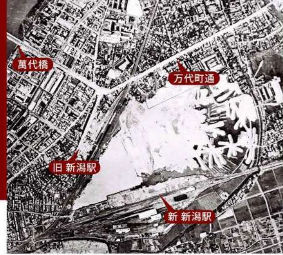
昭和33年(1958)以前 新潟駅前土地区画整理工事の状況
