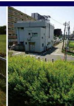
正面に排水機場、その後ろが古信濃川の流れの道です
