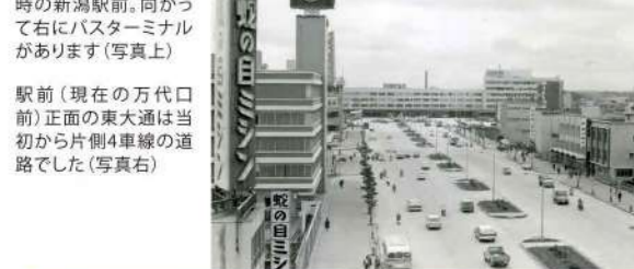
駅前(現在の万代口前)正面の東大通は当初から片側4車線の道路でした(写真右)
