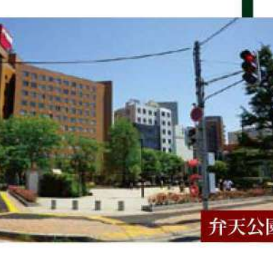
流作場五差路の歩道橋から見た萬代橋方面
