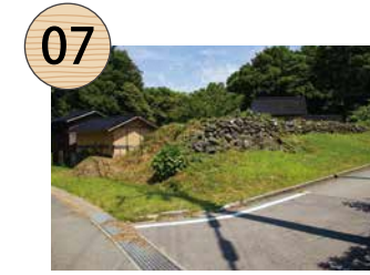
いしづみ 水路あと 石積み水路跡
